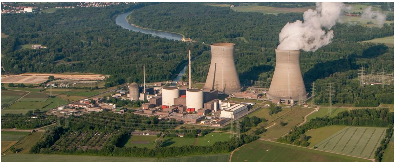
RWE Luftbild, von links: Block A (graues Kuppelgebäude, 1966-1977) mit Abgaskamin, Block B (1984-2017) +C (weißer Zylinder, 1984 - 2021) mit Abgaskamin, Zwischenlager. Kühlturm Block C dampft 2021 noch.
